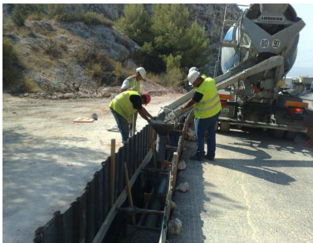
Coulage du béton
