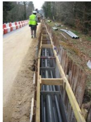
Coupe type d'une liaison souterraine en technique 225 000 V (pose en trèfle)
