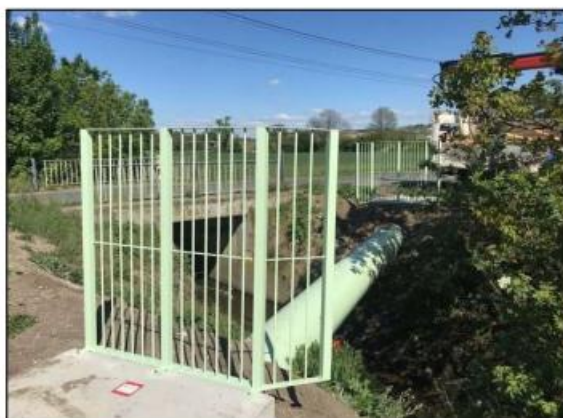
Protection du tube contenant les câbles.
