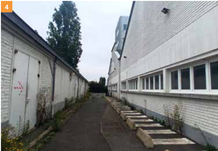
J4.1 - Sites routiers, ferroviaires et autres constructions désafectées sur des surfaces dures (TRANS-FAIRE, 2025)
