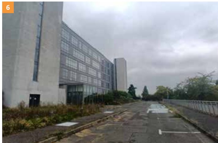
J4.1 - Sites routiers, ferroviaires et autres constructions désafectées sur des surfaces dures (TRANS-FAIRE, 2024)
