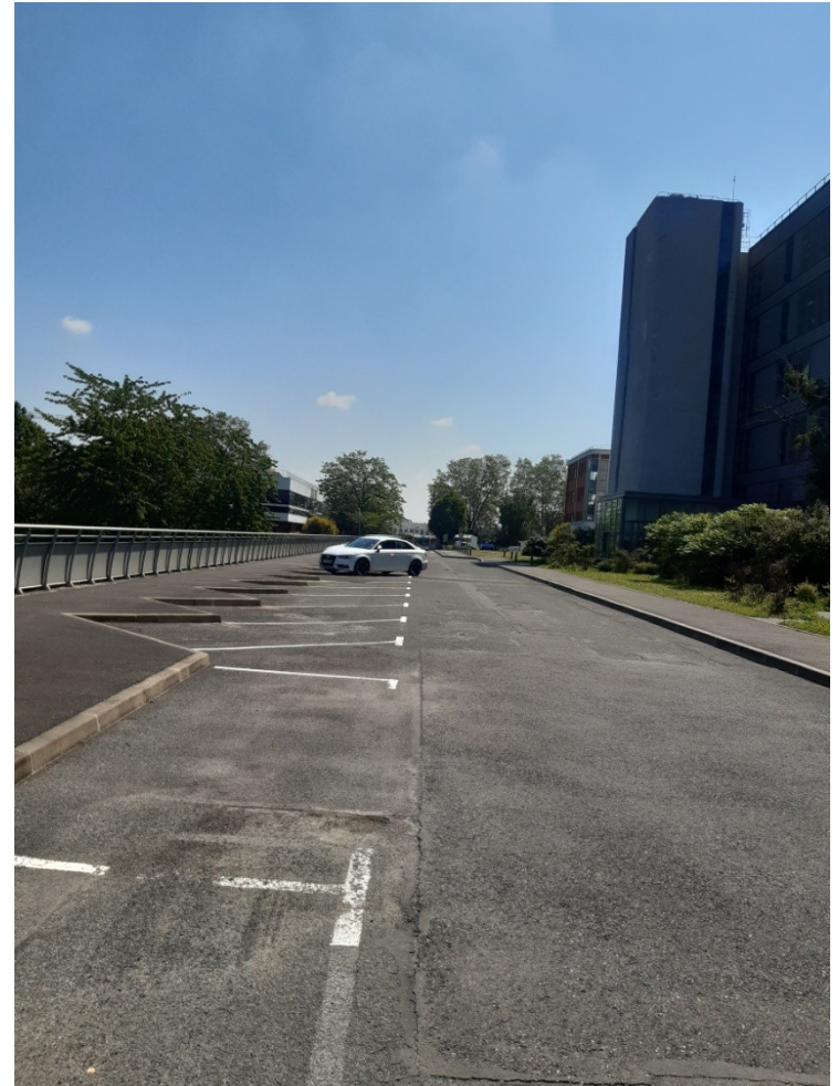
Event de la cuve enterrée de fioul située au nord du bâtiment ASTROLAB
