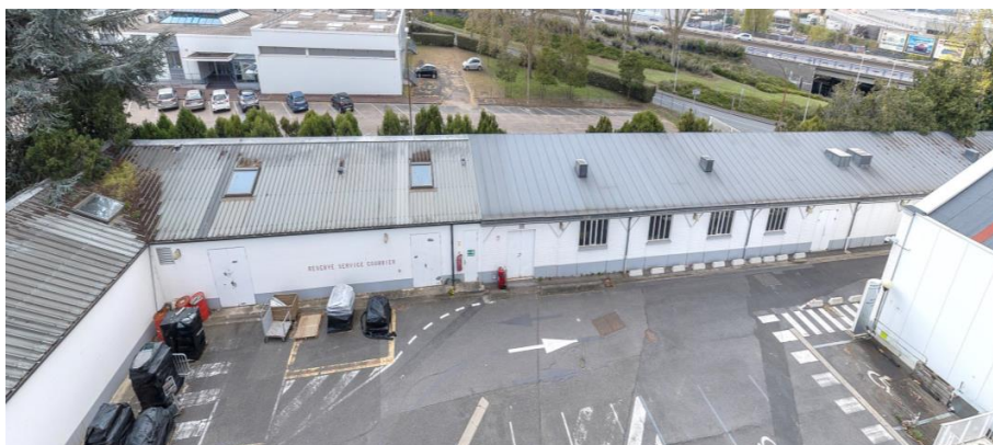
Figure 8 : photo du bâtiment 50
