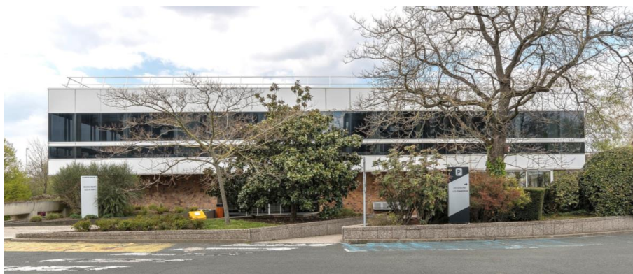
Figure 9 : photo du bâtiment RIE
