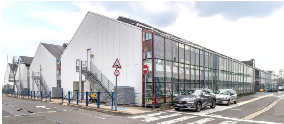
Figure 6 : photo bâtiment SHED / SIMULATEURS
