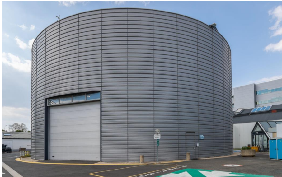
Figure 7 : photo du "bâtiment rond"
