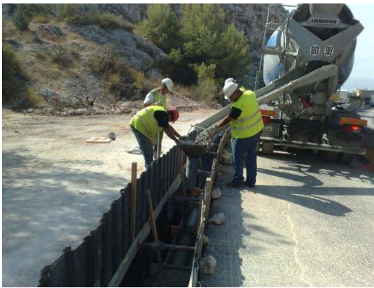
Coulage du béton.
