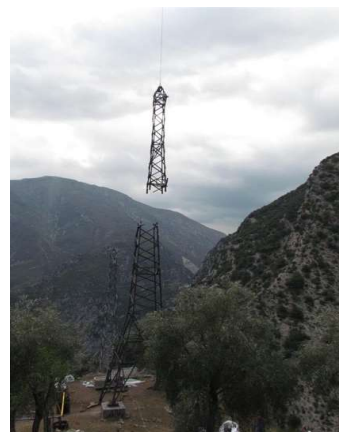
Levage des pylônes à la grue.
