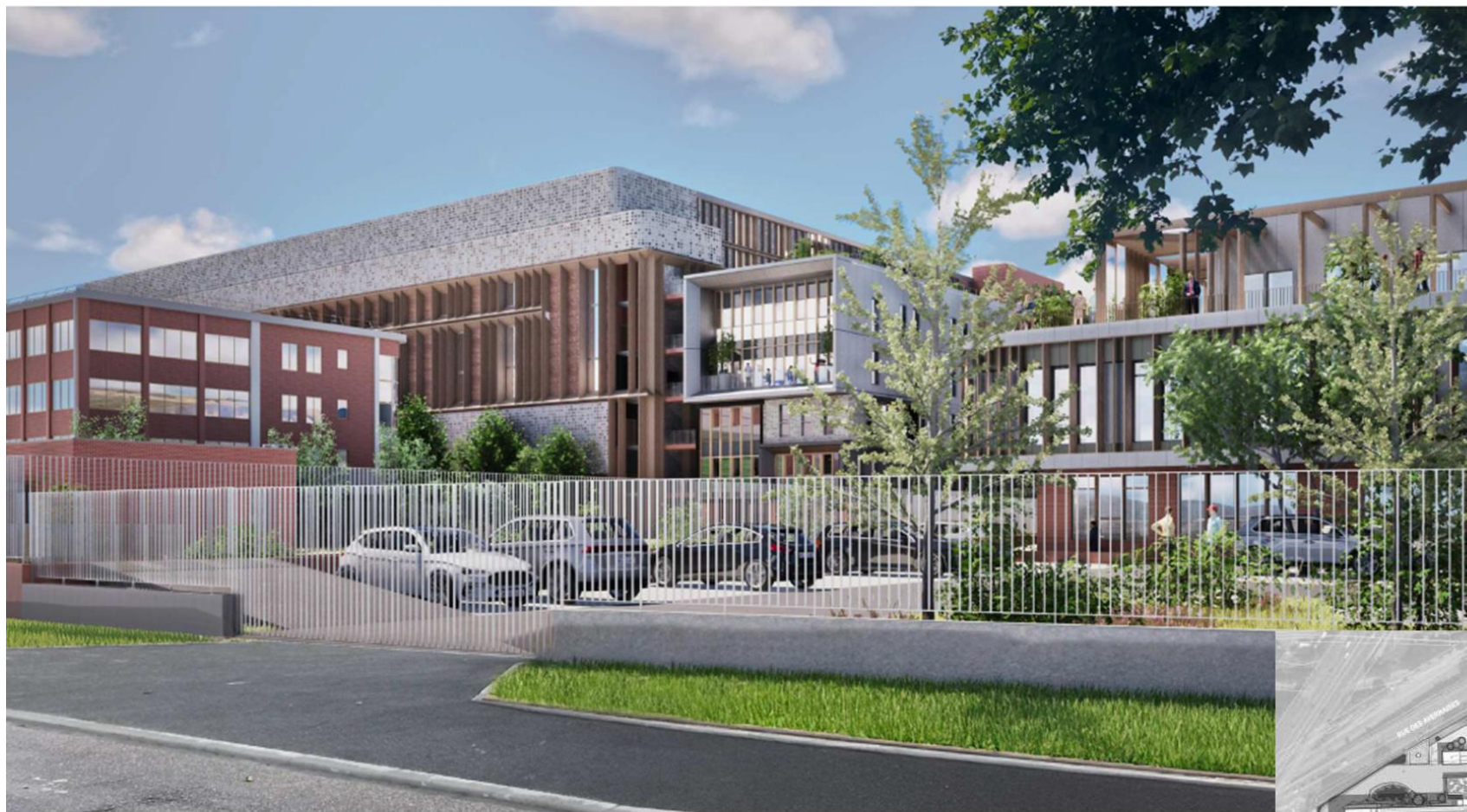
vue depuis l'avenue du Maréchal Devaux
